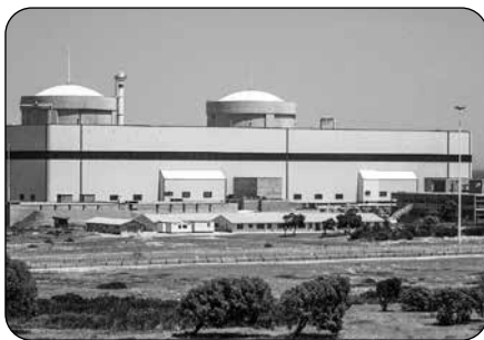
Obr. 1 – Jaderná elektrárna Koeberg
