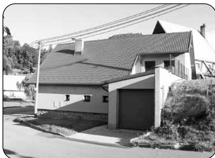
Rekonstrukce hasičské zbrojnice 2021
