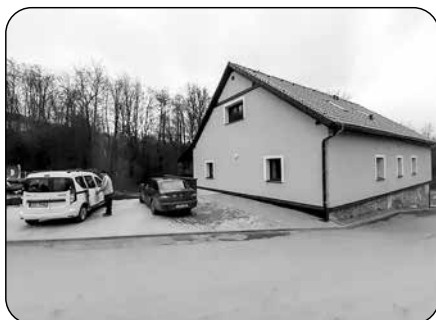
Oprava domu č. 53 v roce 2020
