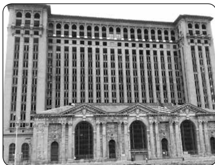
Obr. 5 – Nedokončená budova nádraží Detroit
